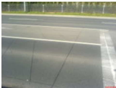
Abbildung 6.1.: Induktionsschleife Straßenverkehrsampel
